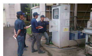
凝集沈殿工程放流水・原水ポンプ停止操作の確認
