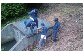
ピオトープのポンプ位置・水位・放流ポンプ停止操作の確認
