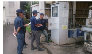
凝集沈殿工程放流水・原水ポンプ停止操作の確認
